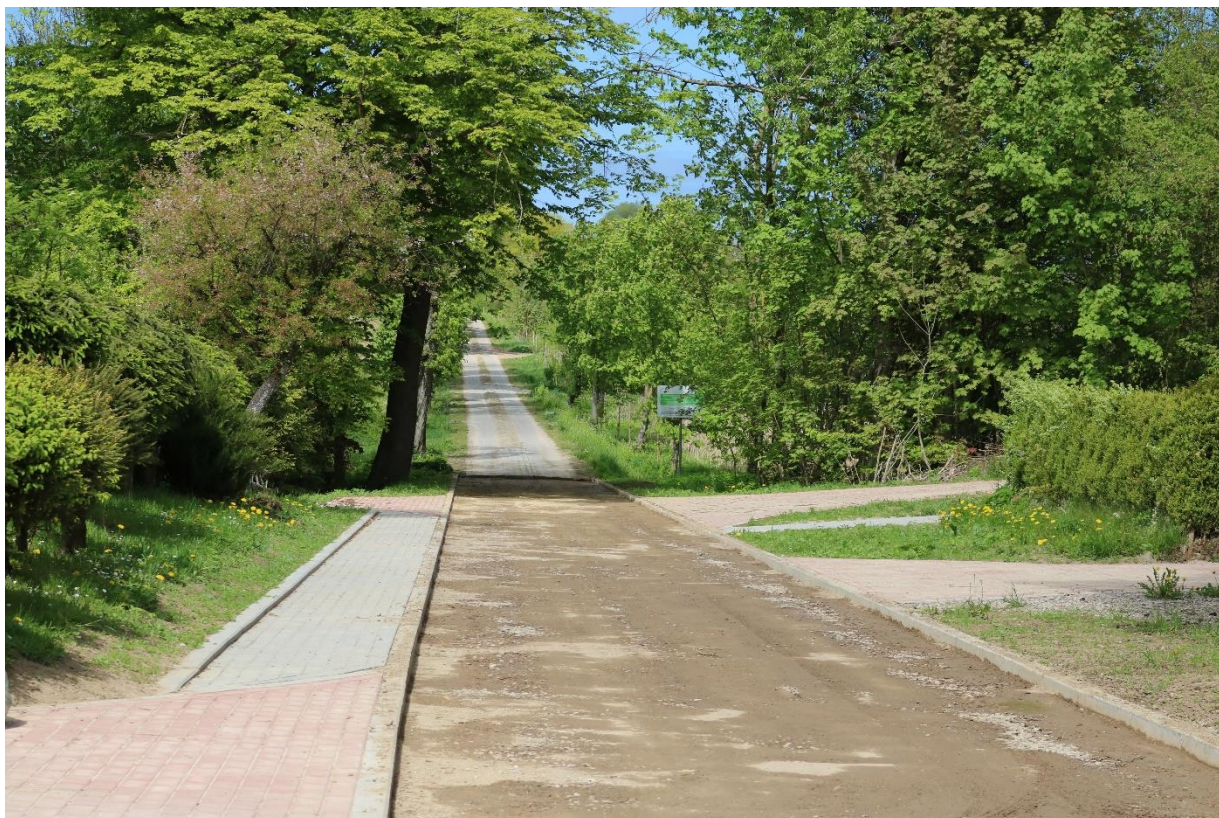
Fot. 36. Przebudowywana droga będzie połączona z wybudowaną w 2020 r. drogą płytową Źródło: Archiwum własne
